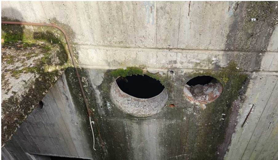
Kernbohrungen neben Treppenabgang:
