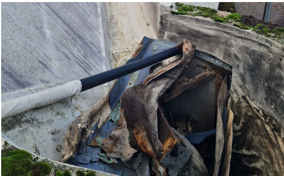
Trog von oben mit geöffneter Membran
