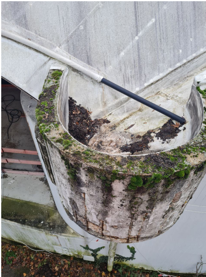
Trog von oben mit Überlappung der Membranen
